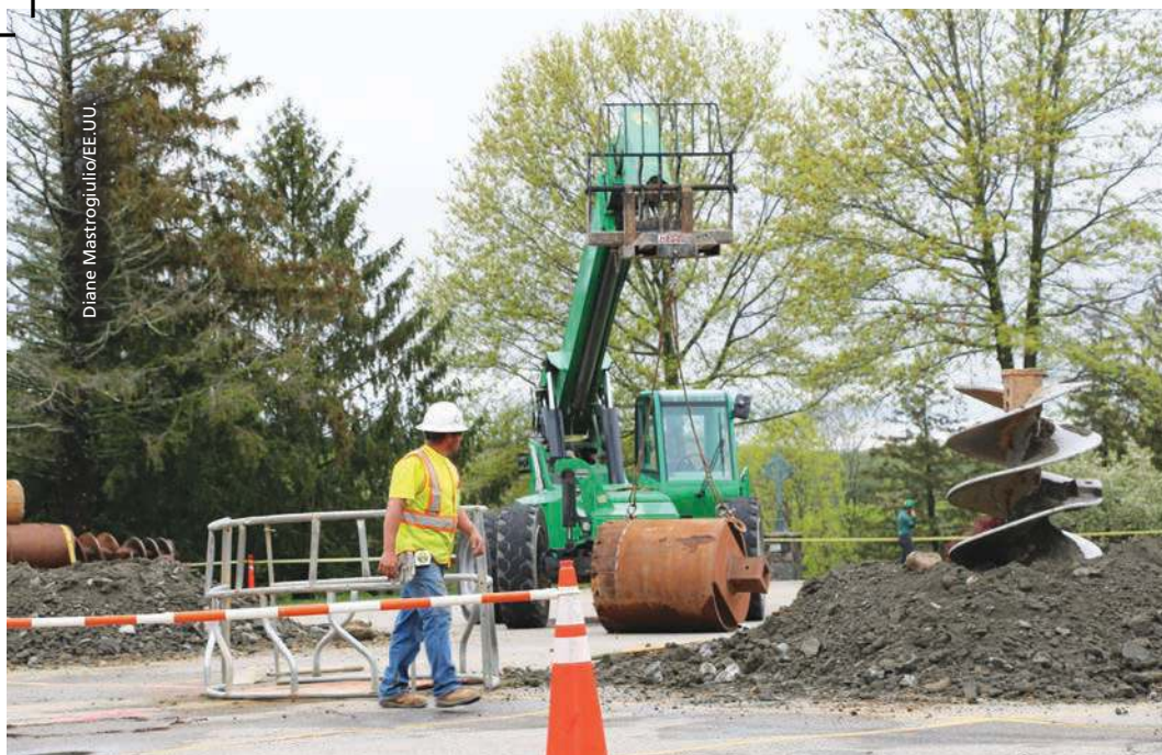
Trabajos de construcción en uno de los estacionamientos en el campus de los Padres y Hermanos de Maryknoll en Nueva York, donde se instalarán marquesinas de paneles solares.
