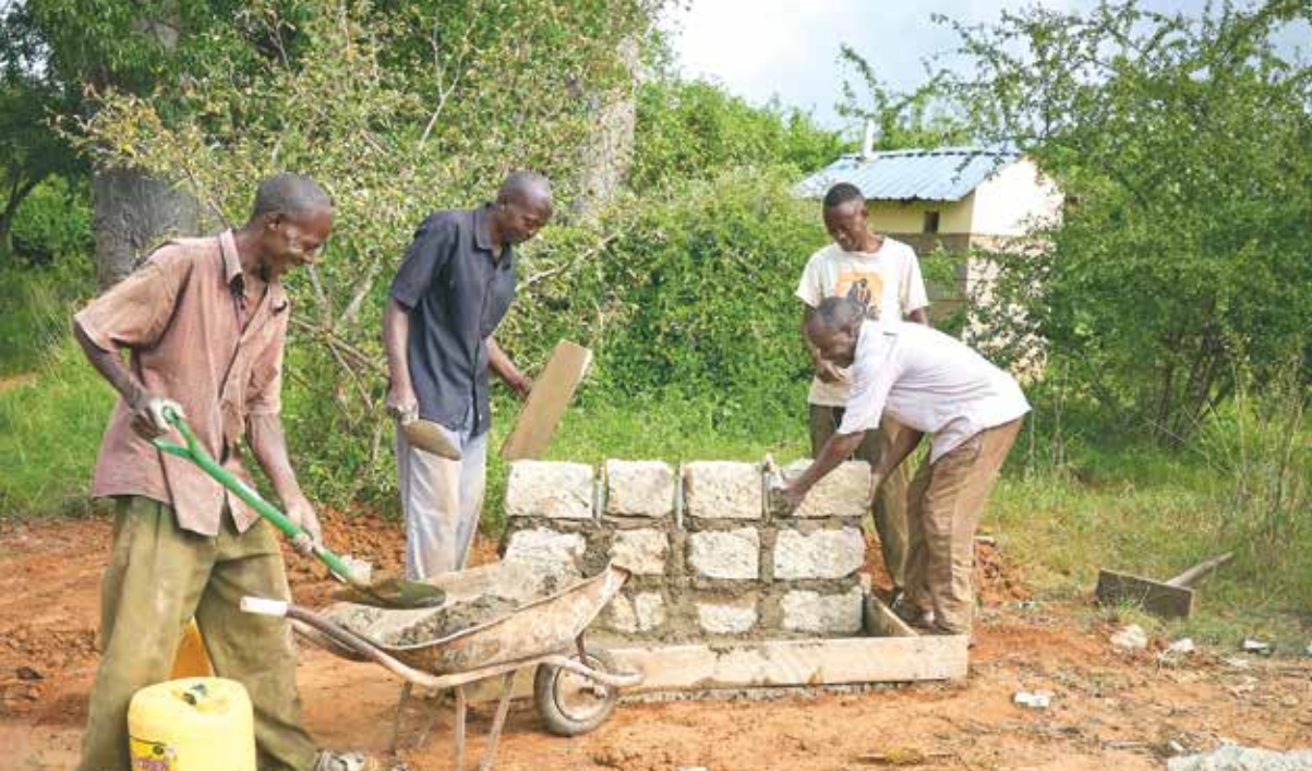
Unos trabajadores dan los últimos retoques a un pozo de abastecimiento de agua en la iglesia de San Miguel Arcángel, en Kamboo, donde los Padres y Hermanos Maryknoll ayudan a transformar vidas. La zona de Kibwezi ha sido devastada por el cambio climático.
